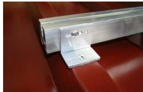
Slika 11: Pravilno pritrjena objemka z nosilno letvijo.
